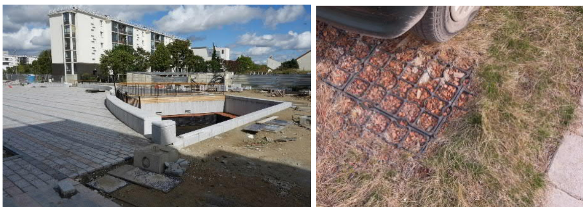
Figure 31 : Aménagements pour la gestion des eaux pluviales Cité Paul Bert. (A) Place centrale avec chaussée drainante et bassin de stockage ; (B) Parking drainant © Martin Seidl 2016
