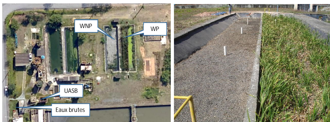
Figure 35 : Le dispositif expérimental de la STEP Arrudas (à gauche) avec le détail des filtres, vus d'aval vers amont (à droite). Coordonnées 19.8951299,-43.8786932
