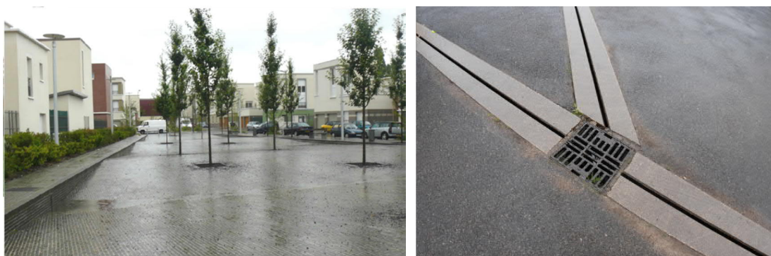
Figure 32 : Le Quartier des Trois Rivières à Stains et ses aménagements pour la gestion des eaux pluviales. (A) place centrale avec mini bassins de stockage à ciel ouvert ; (B) Caniveaux à fentes © M. Seidl 2016 /CD93
