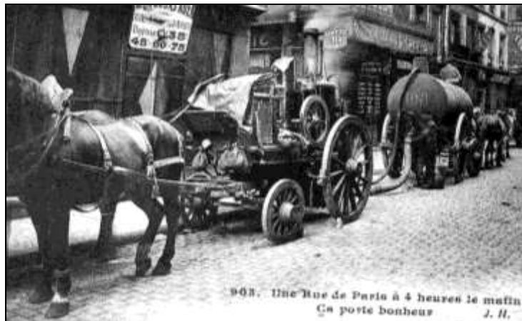
Figure 103 - équipement complet de vidange des fosses fixes (fin XIXe s.)
