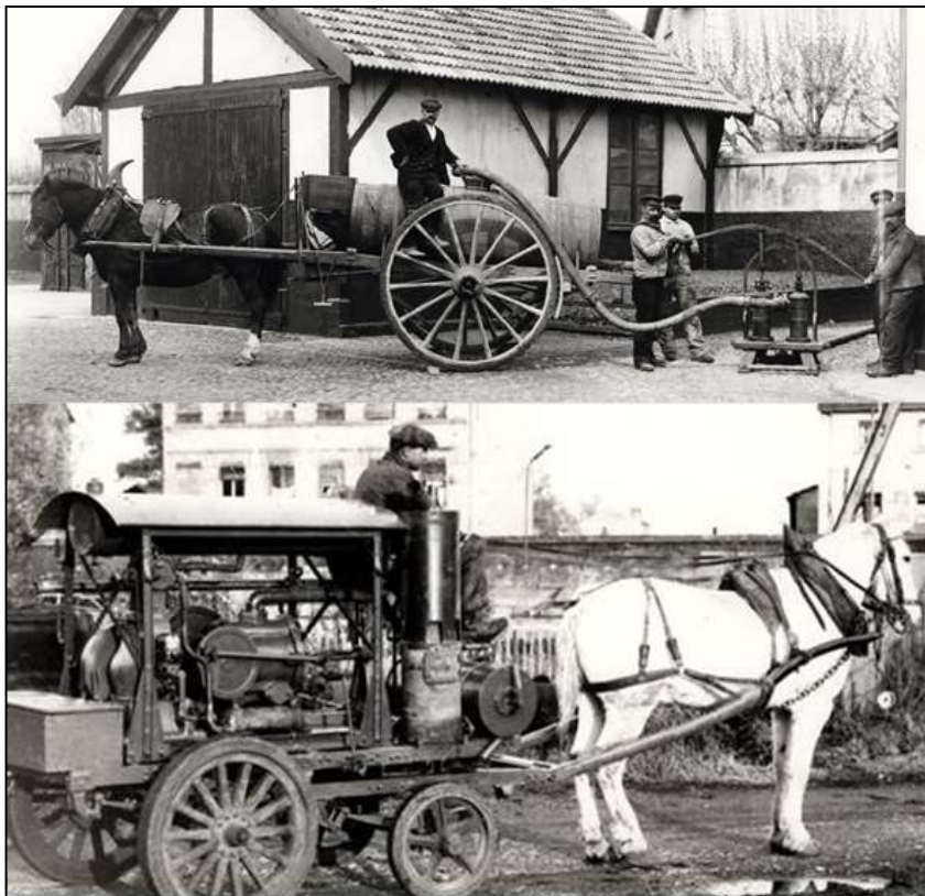
Figure 104 - vidange par pompe à bras et à vapeur, Lyon, UMDP (1890)
