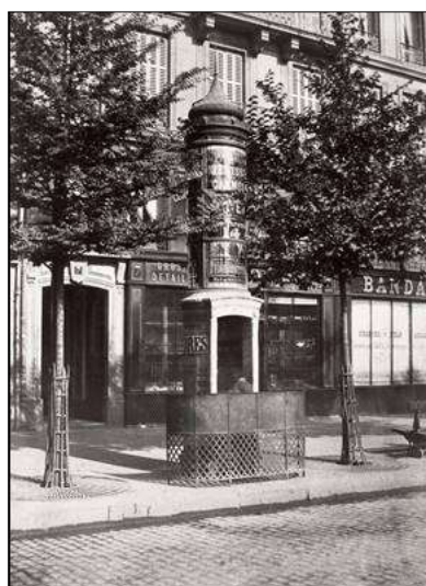
urinoir lumineux à une stalle avec écran, maçonnerie et vitrerie (Cie Delastre)
