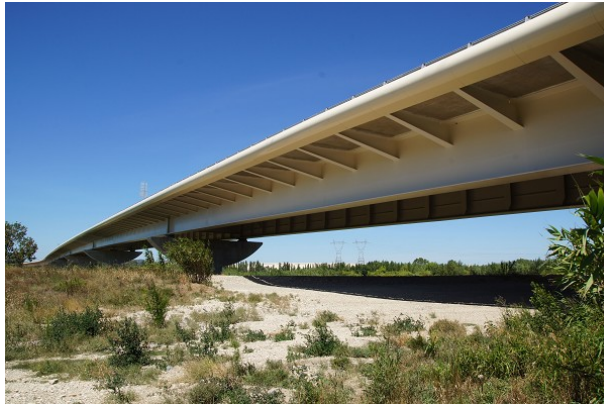
Figure 1.1: The “viaduc de franchissement aval de la Durance par la LEO à Avignon” (credits N. Janberg and Structurae).
