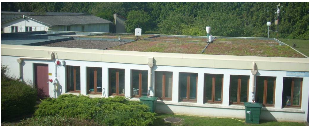
Figure 41: banc d'essai de toitures végétalisées mis en place dans le cadre du projet TGVEP au CETE Ile de France
