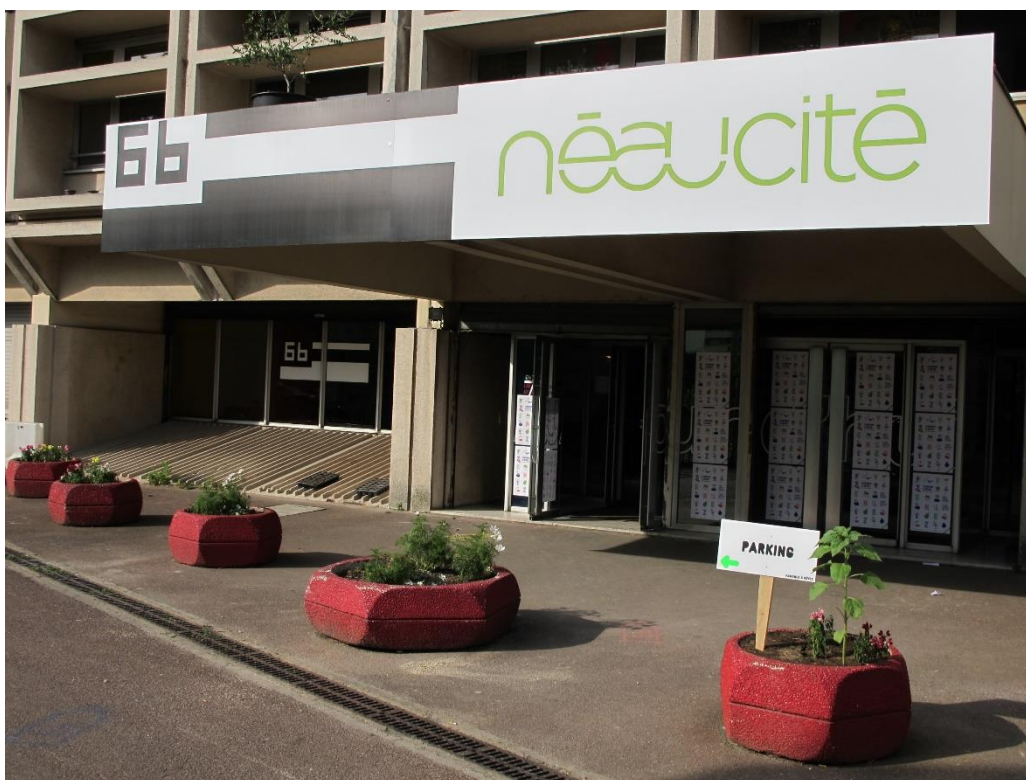
Figure 47 : Entrée du 6b et bureau de vente Néaucité. L'ouverture des ventes s'est faite à l'occasion de La Fabrique à Rêves de l'été 2012 (source : auteur)
