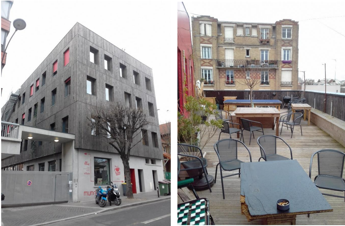
Figure 39 : Le bâtiment Mundo M à Montreuil ; la terrasse partagée au dernier étage (source : auteur)
