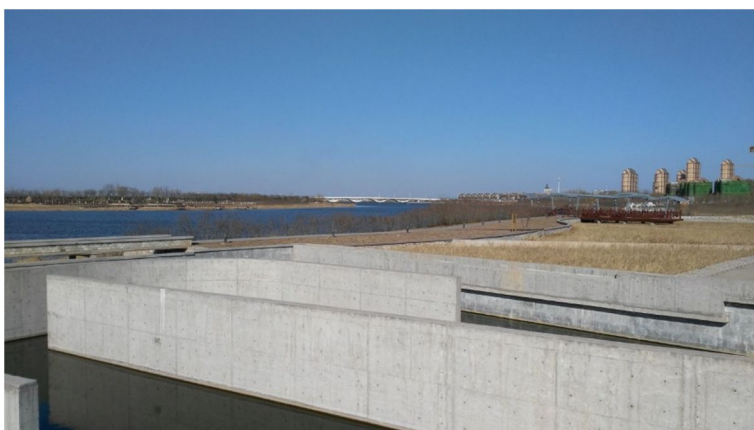
Photo 3 Une des quatre zones de tampon pour les eaux pluviales composée par un canal en béton et des roseaux. ©Yinghao Li 2016
