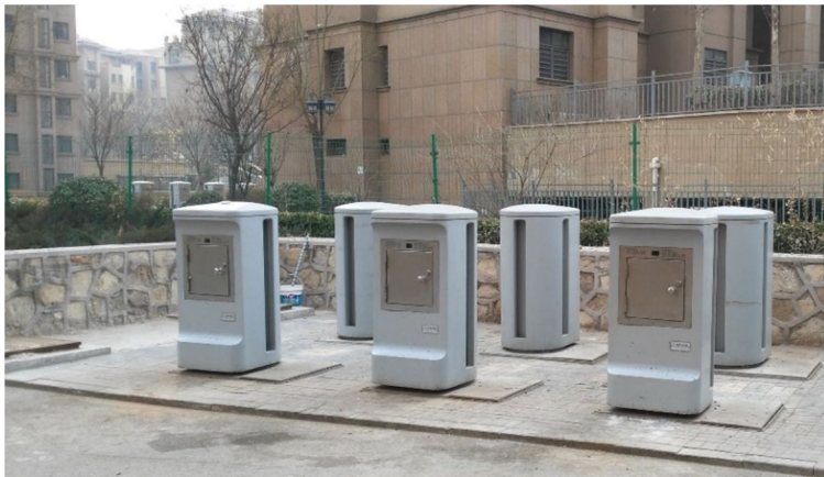
Photo 2 Points de collecte des déchets pneumatiques installés dans un quartier de l’éco-cité de Tianjin. ©Yinghao Li 2016
