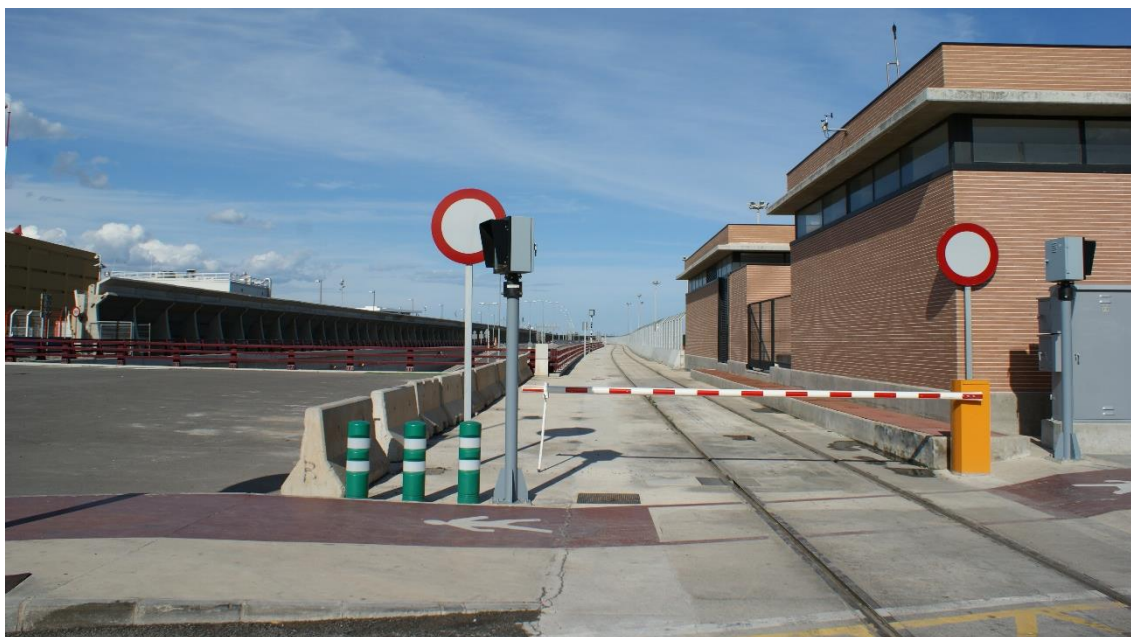
Photographie 18- Accès ferroviaire au port de Valence
