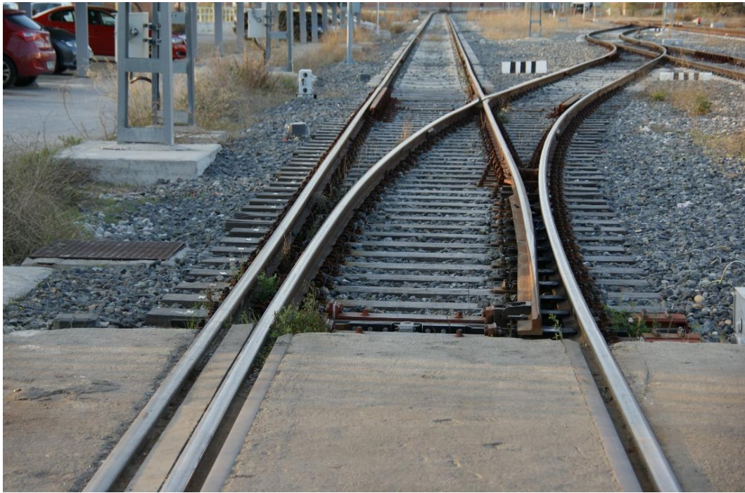
Photographie 1- Aiguillage à double écartement
