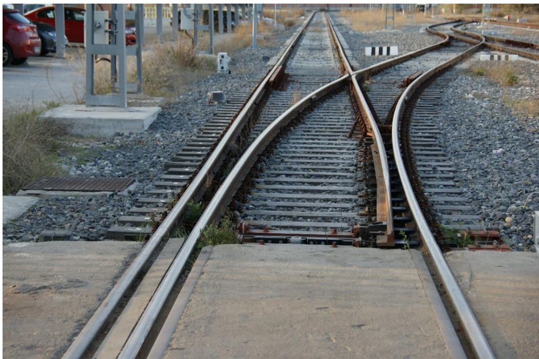
Photographie 1- Aiguillage à double écartement
