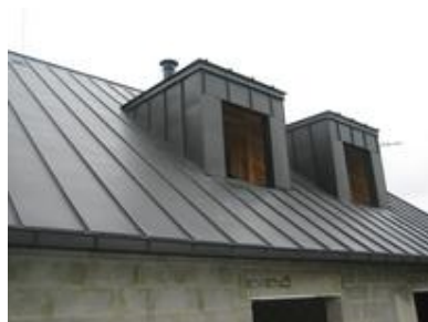
Figure 15 : Toiture en zinc
