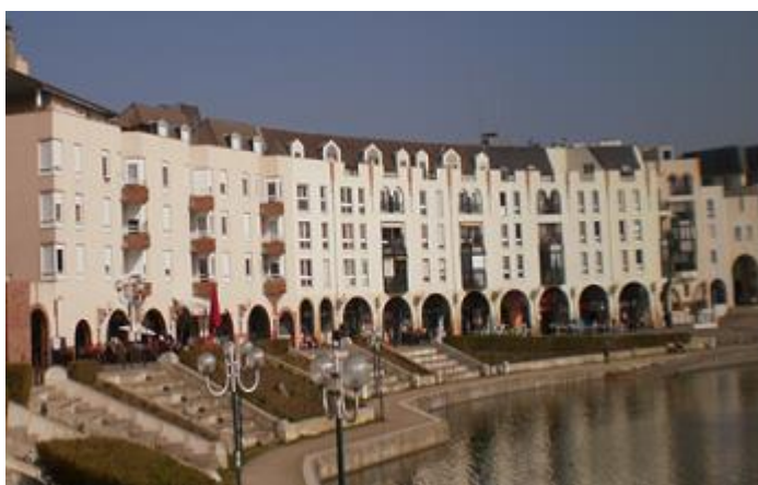
Figure 91 : Les toitures noirâtres du quartier du Port avec des matériaux différents (tuile béton, bardeaux bitumineux...)
