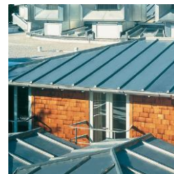
Figure 58 : Couverture en zinc à tasseaux
