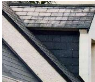
Figure 12 : Ardoise en fibres ciment blanchie
