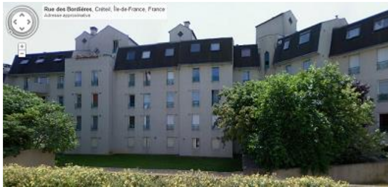
Figure 89 : Réhabilitation du Centre Ancien – Quartier La Bordière : ajouts des éléments en bardeaux bitumeux aux toits-terrasses bi-pentes
