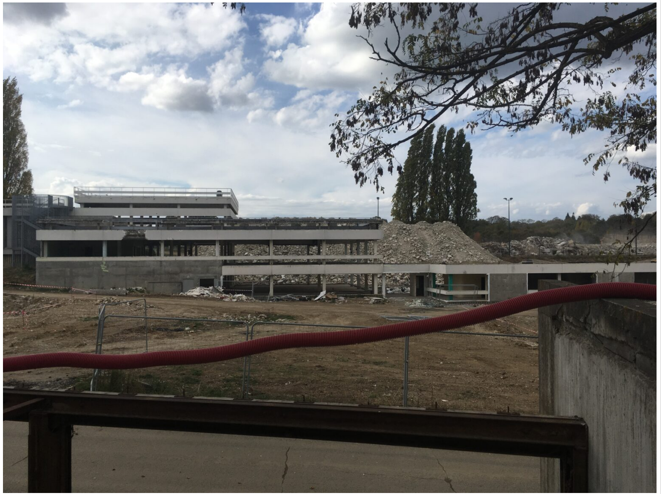
Figure 1 : Démolition en cours de l'Ecole Centrale, octobre 2018, cliché LV
