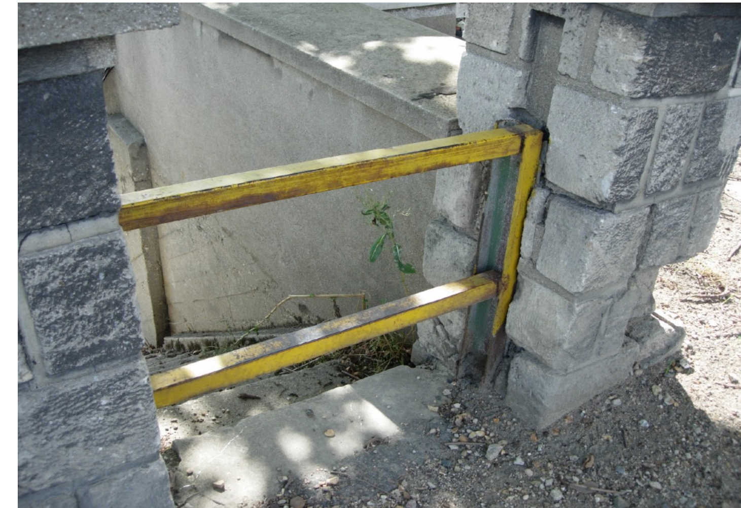
Difficulté de pose des batardeaux
