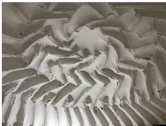
Fig. 14. Une coque en béton coulée sur le gonflable en forme, gonflé.
