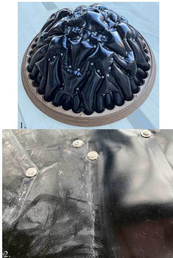
Fig. 13. Le coffrage gonflable avec son support (1). La membrane après décoffrage réutilisable.
