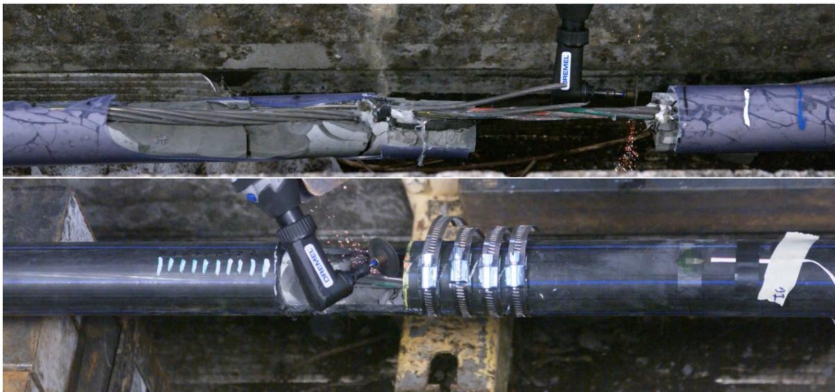
FIGURE 2 – 3<sup>e</sup> découpe du premier monotoron et 2<sup>e</sup> découpe du troisième monotoron
