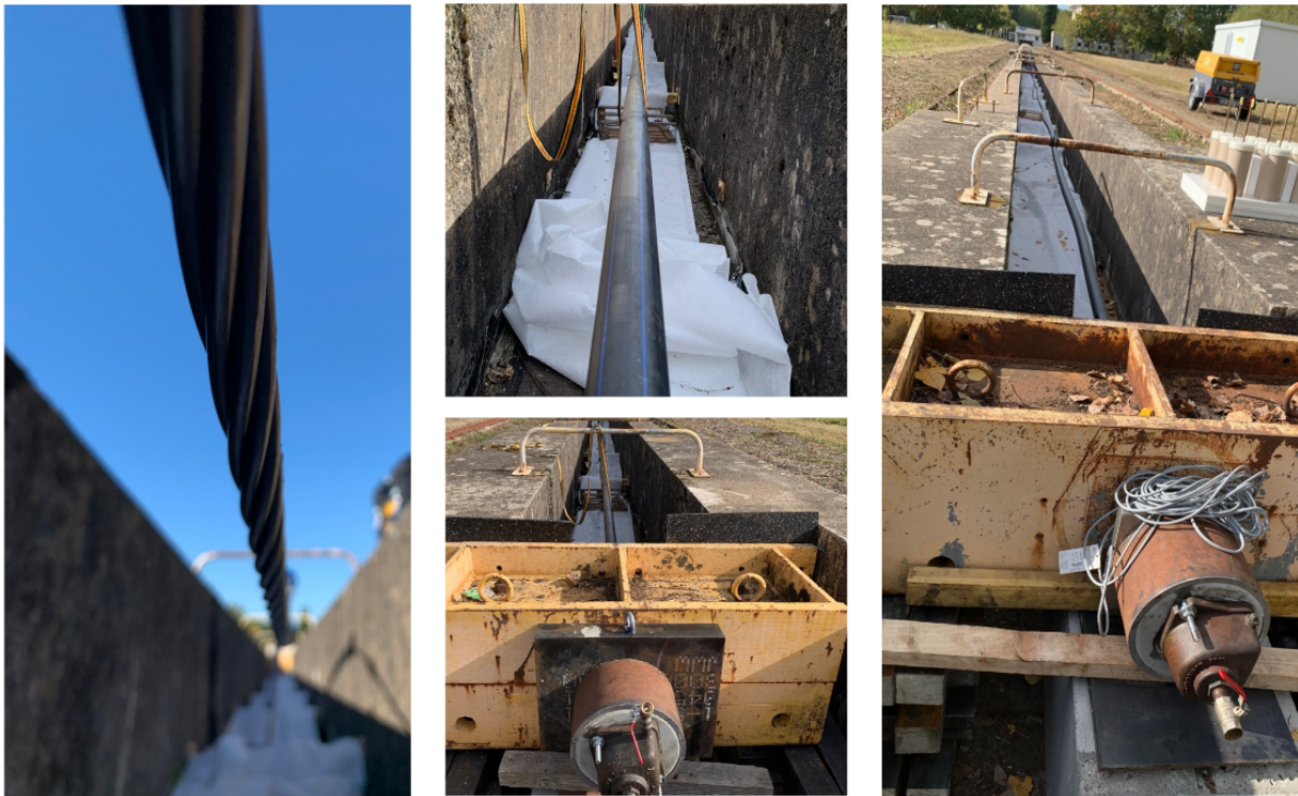
FIGURE 1 – Mise en place du premier monotoron
