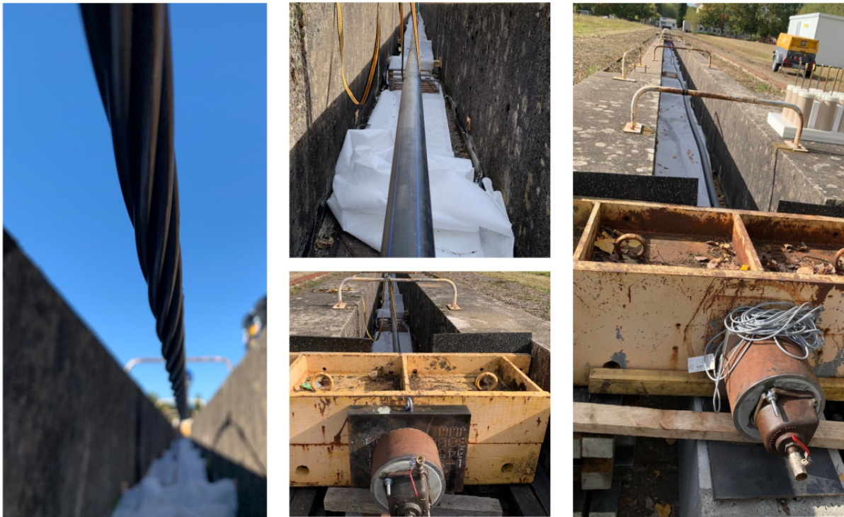
FIGURE 1 – Mise en place du premier monotoron
