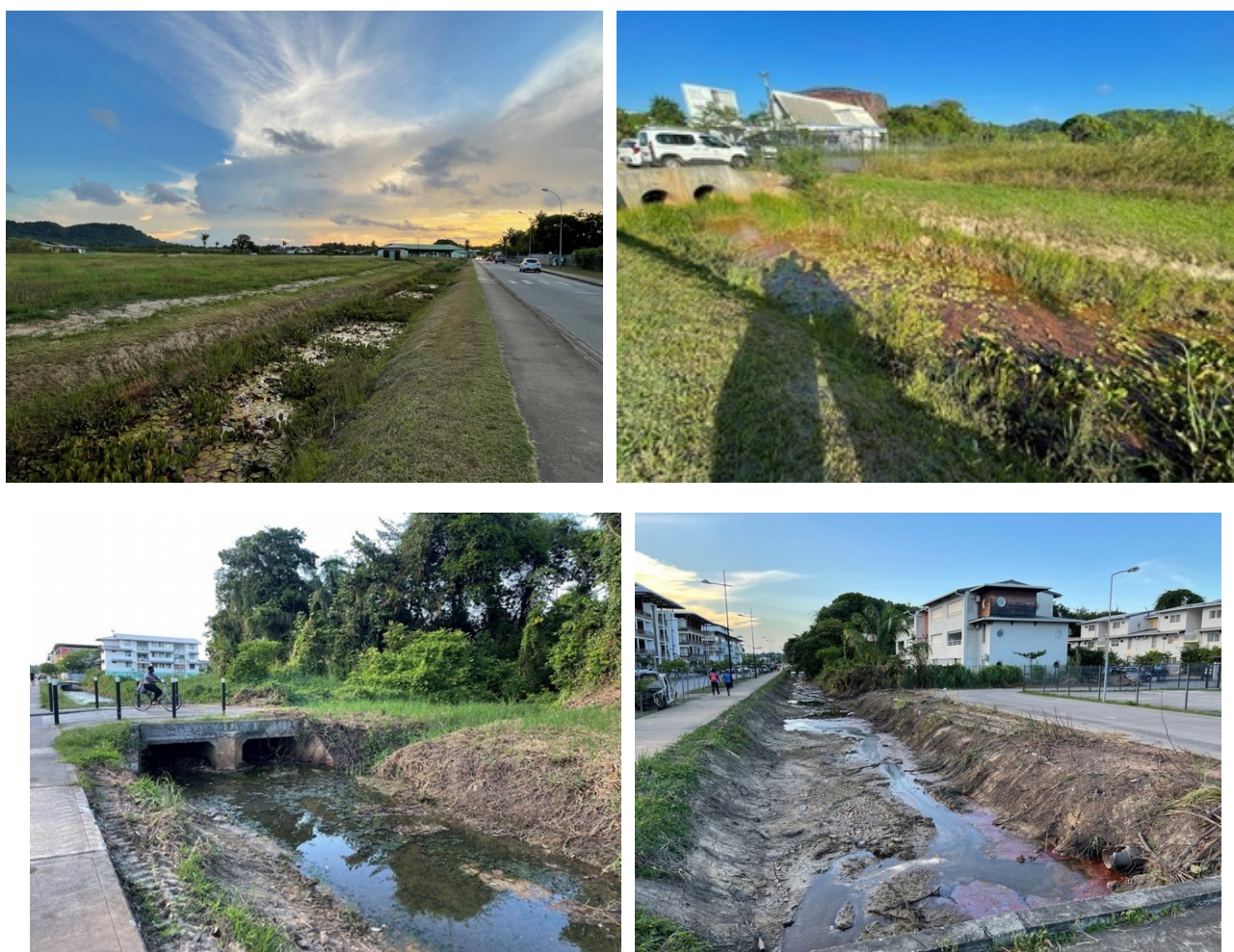
Illustration 5 : En haut, le Canal Michotte, Rémire – Arboré ou géonatte avec couvre-sol (Crédits photos : Astrid Abel). En bas, le Canal Hibiscus, Cayenne. Solution proposée : Enrochement avec héliophytes (Crédits photos : Astrid Abel).
