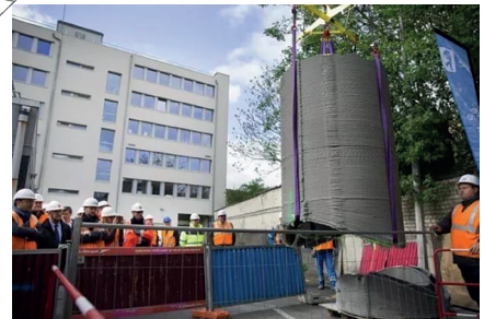
Figure 2a. Design d'un regard de 1,5 m x 1,5 m x 2,3 m d'après relevé sur conduite existante pour impression 3D © XtreeE, 2018.
