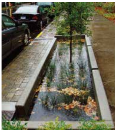
Figure 2.2 – Représentation simplifiée d'un dispositif de gestion à la source des eaux pluviales (© Portland Green Streets tour map, 2007).
