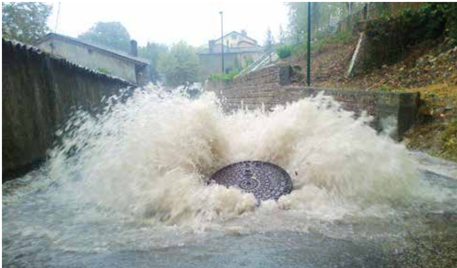
Figure 0.1 – Débordement d'un réseau séparatif en charge (© Le Progrès).
