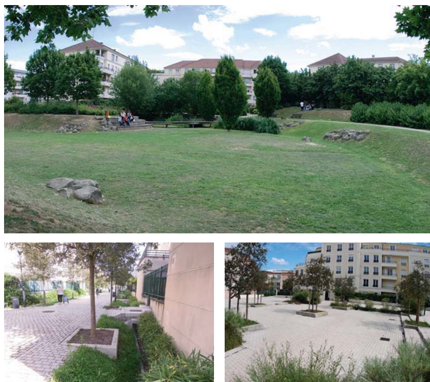
Figure 1. Vues des techniques alternatives du Clos Saint-Vincent. A : Bassin de rétention enherbé dans le jardin des artistes ; B : Noues bordant le mail central ; C : Place inondable à l'ouest © Martin Seidl 2014
