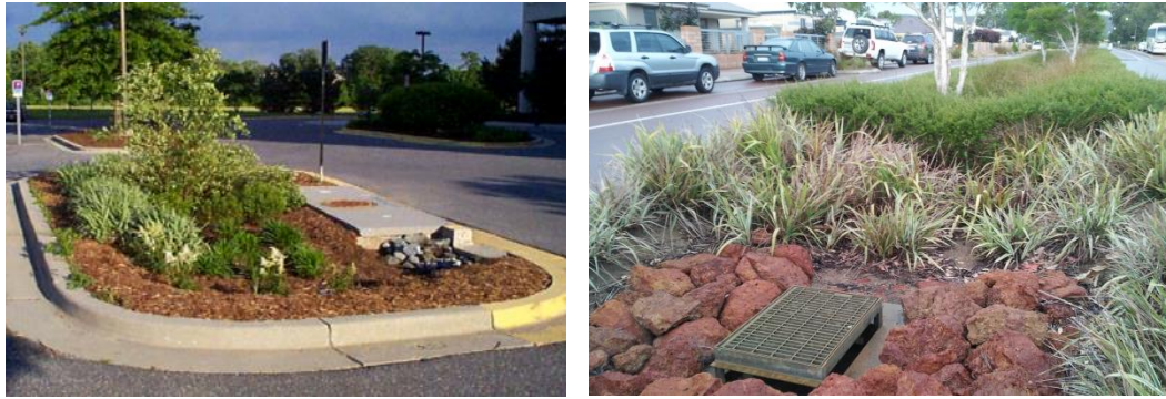
Figure 7 : Exemple d'un ouvrage typique (a) de biorétention aux Etats-Unis (NCDWQ, avec permission) et (b) de biofiltration en Australie (Emily Payne, Monash University, avec permission)
