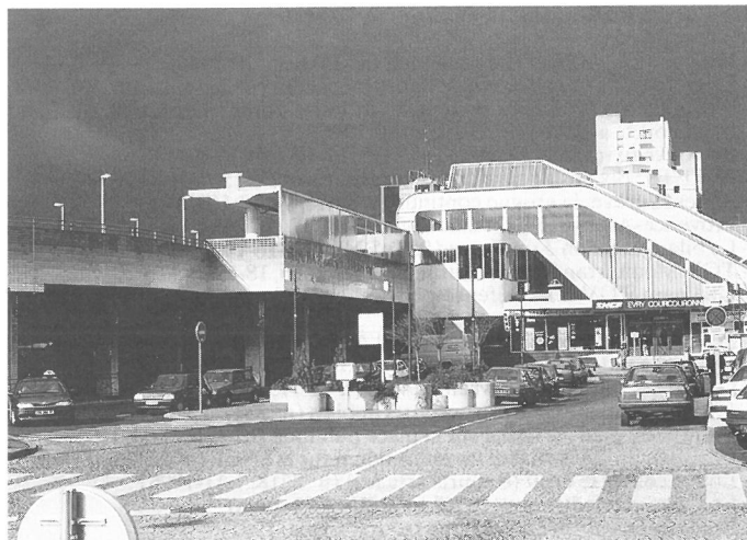
Fig. 4. La gare SNCF d'Évry-Courcouronnes est le plus gros point nodal du département de l'Essonne. La voie ferrée est en souterrain, la gare routière des lignes départementales est, à gauche, au niveau du sol, couverte par le viaduc et la gare du tronc commun des lignes TICE, dont on aperçoit les abris de protection (photo A. Sutter).
