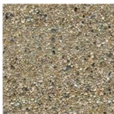
Béton de trottoir et dalle en béton
