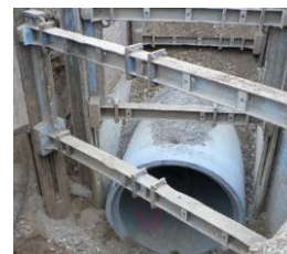
Béton de réseau
