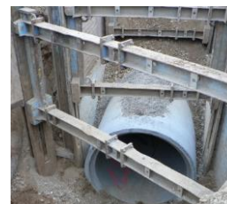
Béton de réseau
