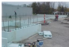
Béton de construction (préfabriqué et armé)
