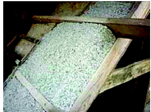
Fig. 1 : utilisation du béton de chanvre pour l'isolation des toitures
