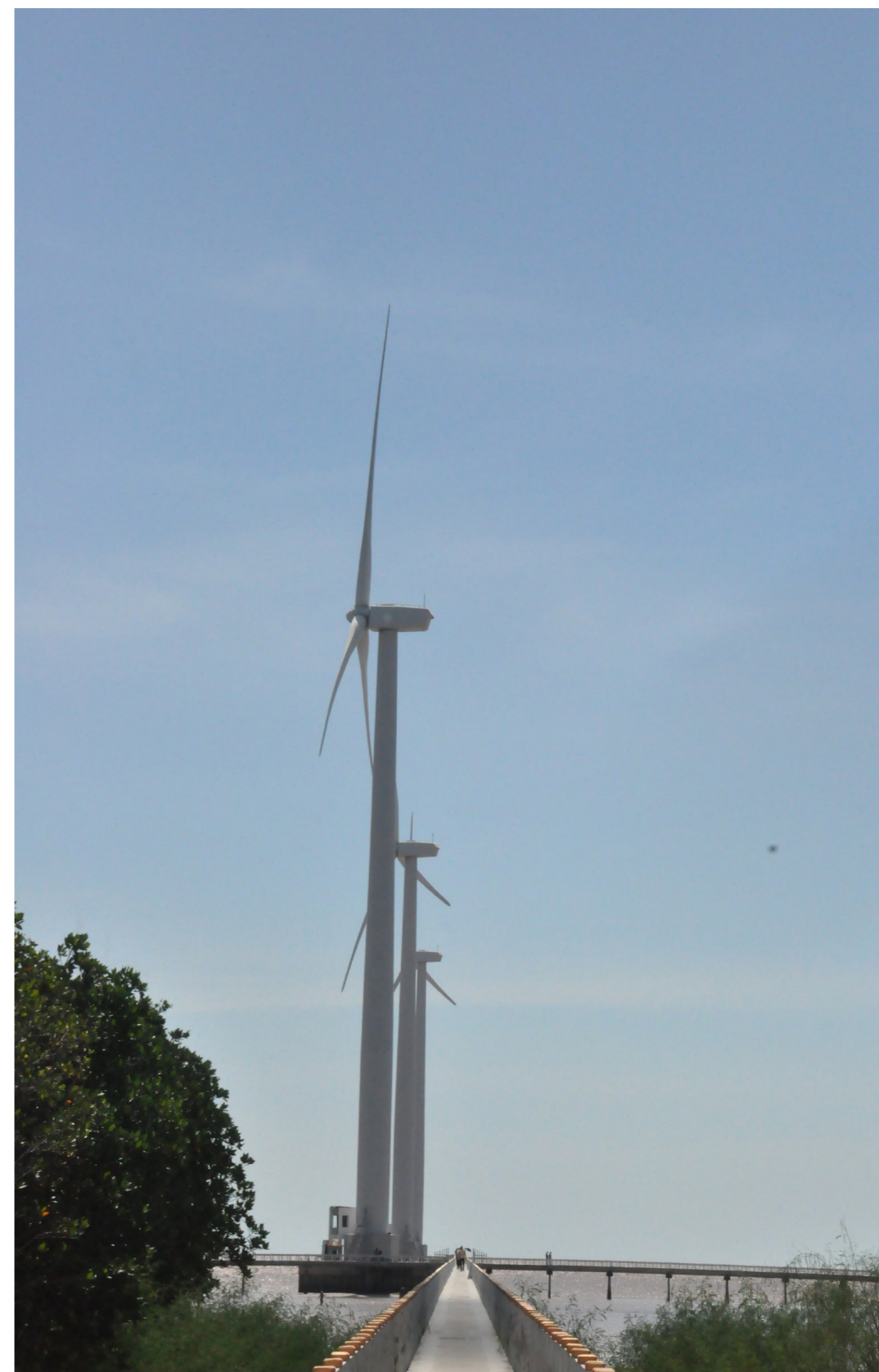
Wind Electricity - Bac Lieu
