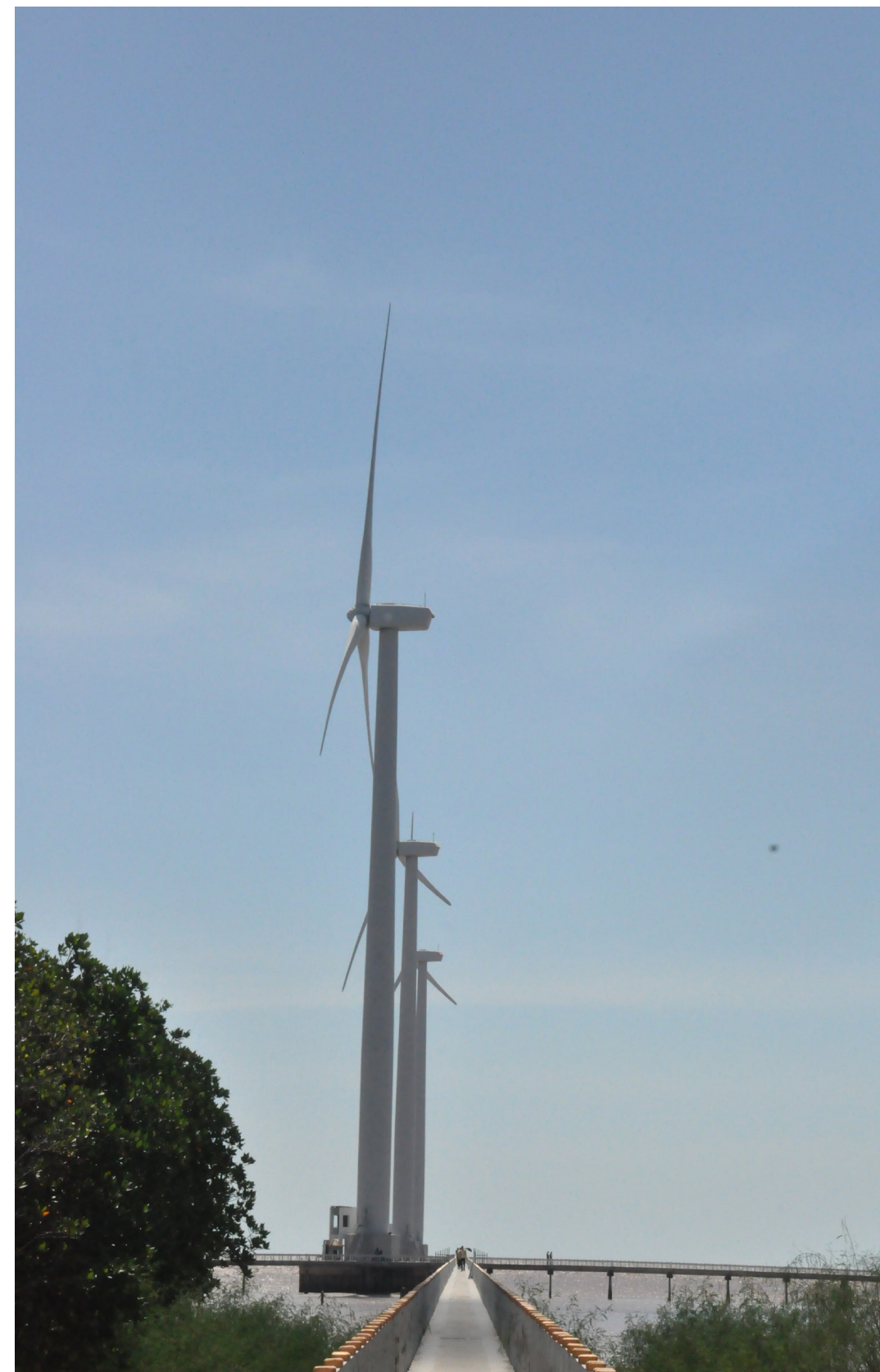
Wind Electricity - Bac Lieu
