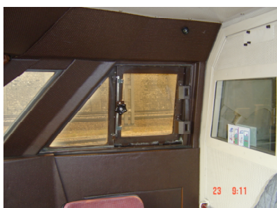
Ouvrant dans le poste de conduite du TGV
