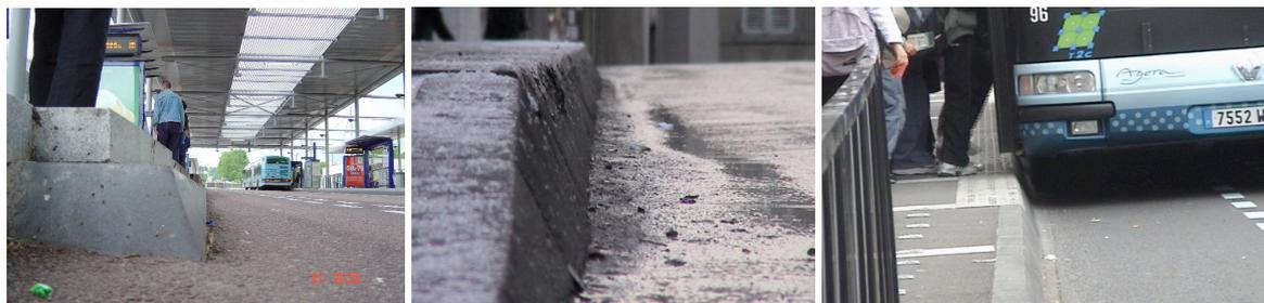
Bordure de trottoir à Rouen sur la ligne Teor (1° photo) et Clermont-Ferrand sur la ligne 14 (2° photo) et accostage au plus près du quai d'un bus de la ligne 14 en conduite manuelle. Les roues touchent le trottoir.
