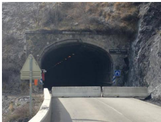
Tunnel du Chambon, Isère
