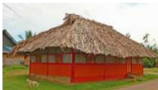
Fig.2. Photographie du carbet associatif sur l'aire commune du village d'Espérance à proximité de Saint-Georges de l'Oyapock
