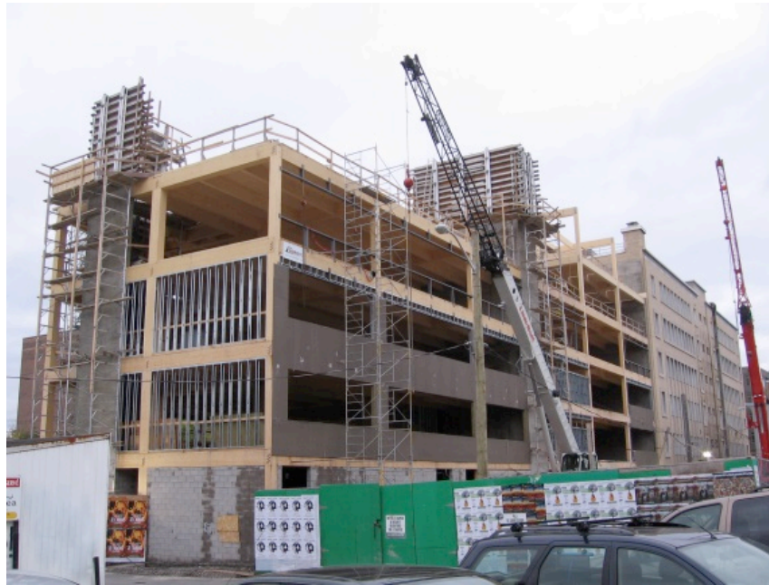
Fig. 2 : Bâtiment en bois lamellé-collé de 6 étages
