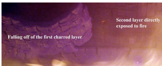
Fig.4 Détachement des couches dans le CLT – PU exposés au feu
