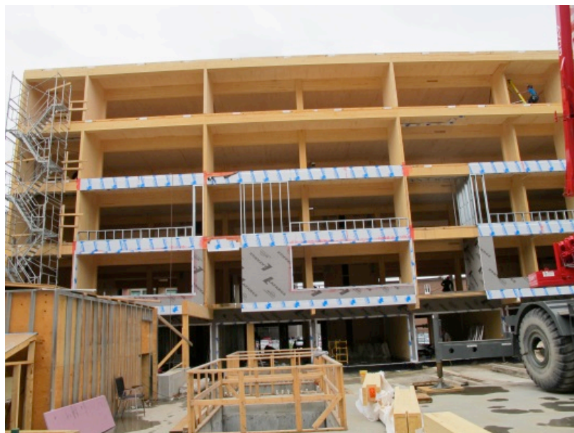
Fig. 1 : Bâtiment en CLT de 6 étages à Québec
