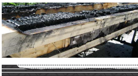
Fig.3 Section réduite du CLT après l'essai au feu
