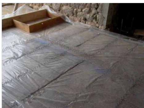
FIG. 1 – Plancher mixte bois-béton.
