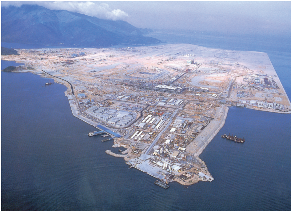
FIG. 7. HONG KONG, CHEK LAP KOK ISLAND, LAVORI DI COSTRUZIONE DEL NUOVO AEROPORTO, ULTIMATO NEL 1998. FONTE: HONG KONG GOVERNMENT.
