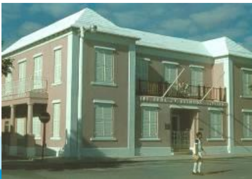
Toit en pentes blancs
