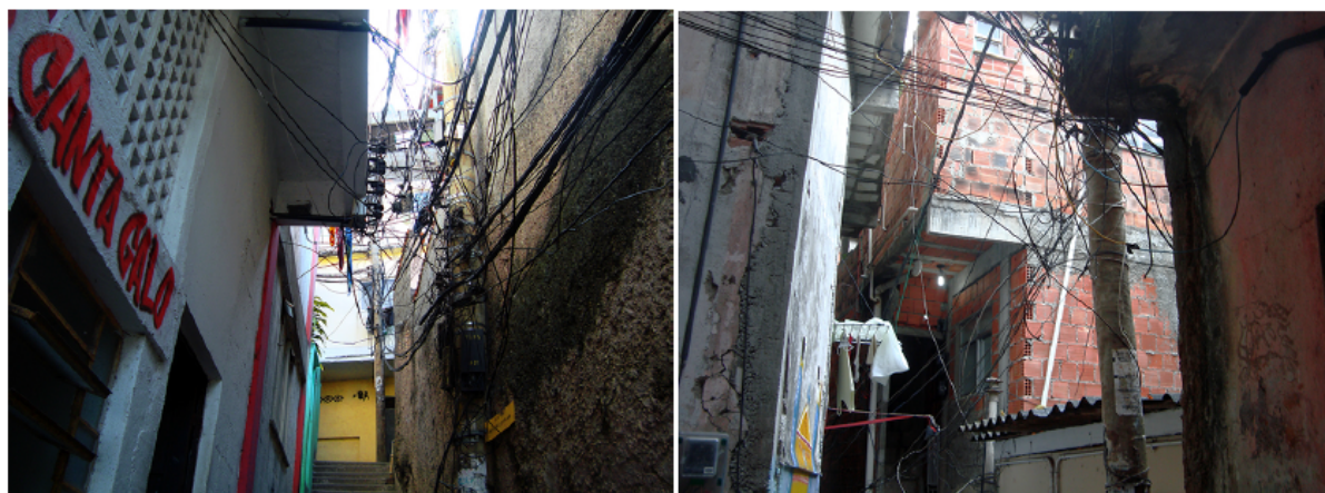
3. Précarité du réseau électrique après la régularisation du service (Pilo', 2011)
