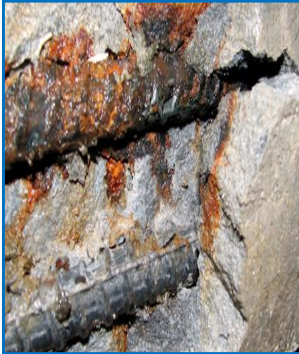
Corrosion des armatures et altération du béton d'enrobage
