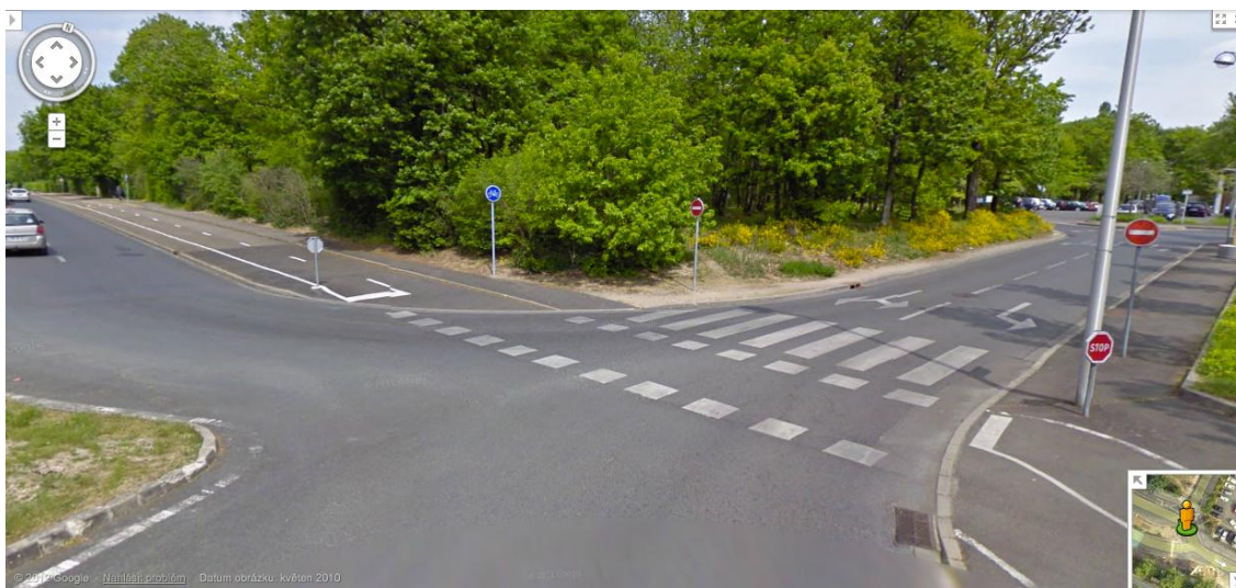
Obr. 2. Detail pěší cesty vedoucí souběžně s cyklostezkou v řešené části Orléans dle kamery StreetView. StreetView umožňuje získat detailní informace včetně svislého a vodorovného dopravního značení.
