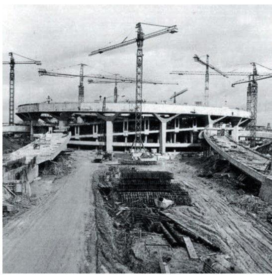
FIG. ◆ 20 || Roissy, l'aérogare 1 en construction, 1971-1972. Les travaux de construction s'engagent, spectaculaires. Le bâtiment est ouvrage d'art, immeuble, architecture du mouvement. Le matériau de prédilection est le béton : nu comme la pierre pour affirmer la dimension brutaliste de la forteresse, ou sculpté par Volti, pour exprimer la poésie architectonique d'une matière encore trop peu connue. Andreu soulignera l'importance que revêtent à ses yeux, la «vérité et l'intelligibilité nécessaires de ce que la construction donne à voir [de ce] sur quoi l'architecture repose. [...] Le dépouillement et la nudité seuls étaient vrais, et donc, je franchissais ce pas sans scrupule philosophique, étaient seuls beaux.»
