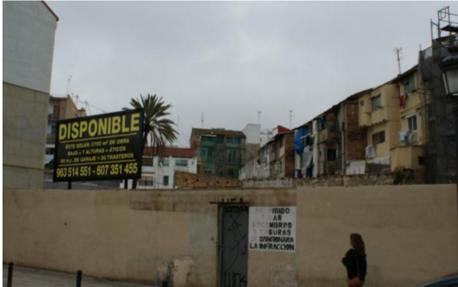
Immeubles vétustes et terrains disponibles à proximité de la gare
