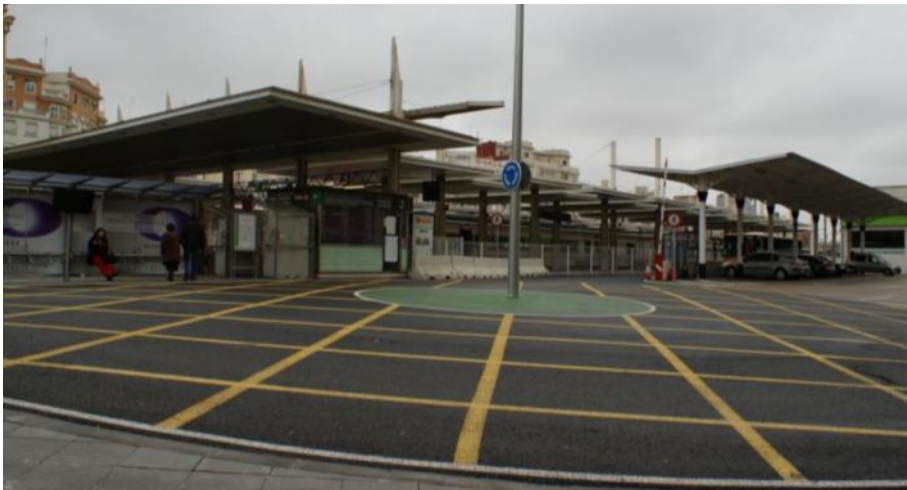
Station de bus pour la navette entre les deux gares
