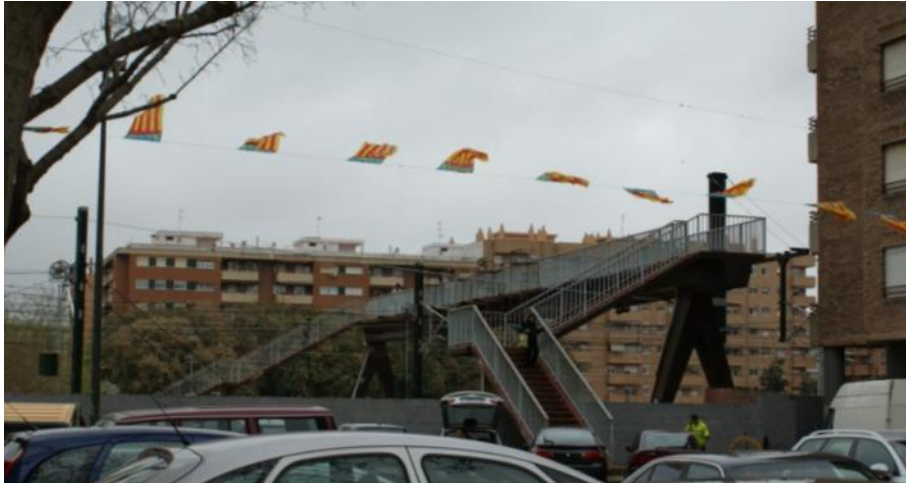
Passerelle permettant aux piétons de traverser les voies ferrées
