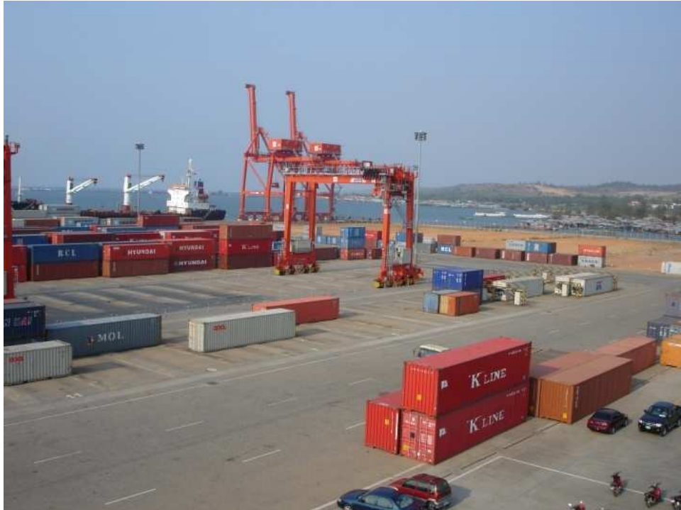
Photographie 3 : Le terminal conteneurs du Port autonome de Sihanoukville
