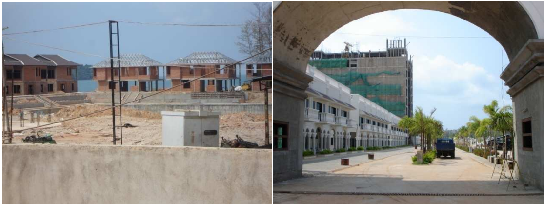
Photographie 5 : Des complexes résidentiels de types différents en construction
