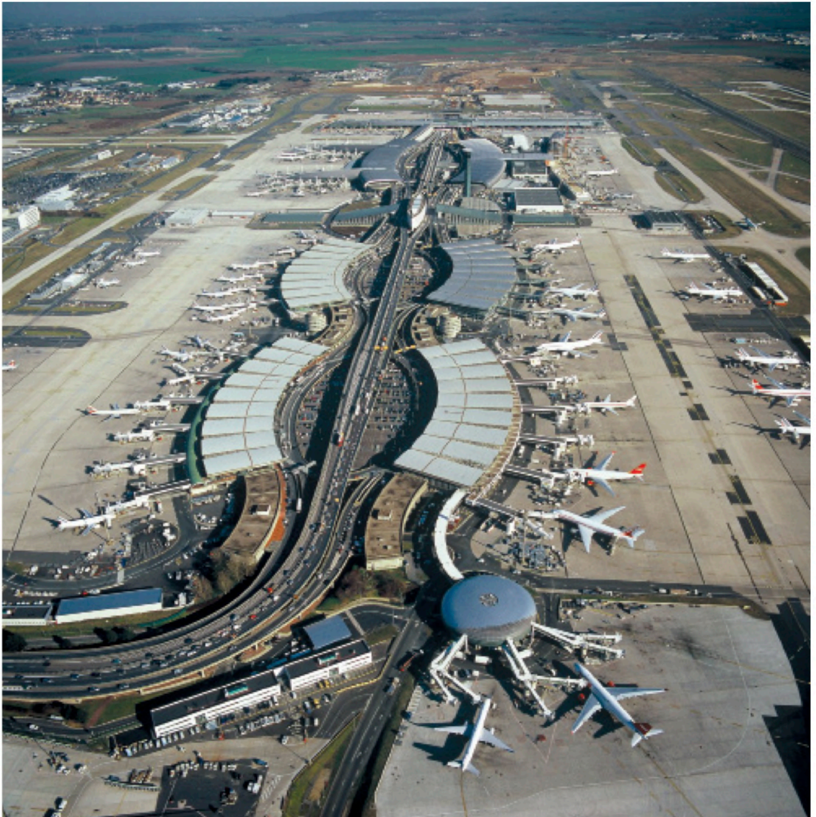
Aerial View of Roissy 2, 2005, Source Photothèque Aéroports de Paris.
