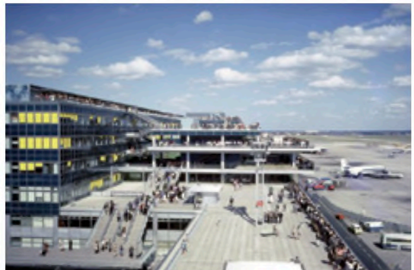
The "megastructure" of Orly Sud Terminal, circa 1963, Source Photothèque Aéroports de Paris
