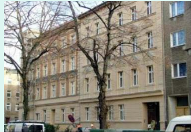
Immeuble à Berlin ITE en façade: 14 cm avec reconstruction du stuc
